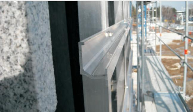
pojačanu nosivost Sa aluminijumskom potkonstrukcijom se postiže, na fasadi, istovetan rad profila kao i kod aluminijumskih fasadnih površina -prozora, a koje su nekad i zastupljenije na fasadnim površinama.
