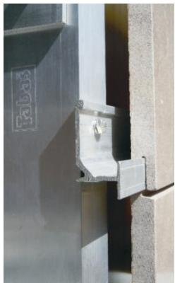
U sistemu ventilisanih fasada kao savremenog načina rešavanje spoljnih vertikalnih površina objekta posebno mesto zauzimaju rešenja ventilisanih kamenih fasada jer imaju niz specifičnosti u odnosu na druge materijale.
