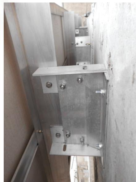
strukcije objekta, to je kombinacijom profila iz sistema Tabaš omogućeno i „pokrivanje“ udaljenja koja su bila i do 500mm. Na taj način nije potrebno građevinski pripremiti tu fasadnu površinu, izradom erkera, kaskada, lažnih greda, itd., što donosi uštede, jer na ravnu – vertikalnu površinu se može uraditi bez problema odgovarajuća „plastika“.
