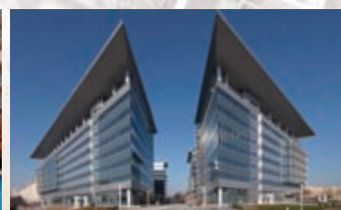
Poslovni objekat, blok 26 – Isporuka i ugradnja 8000m 2 ker. pločica i granitne keramike i građevinske hemije Mapei
